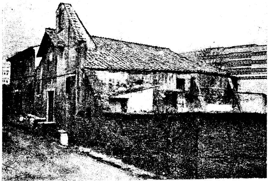
Aspetto esterno della chiesa prima del restauro in corso
